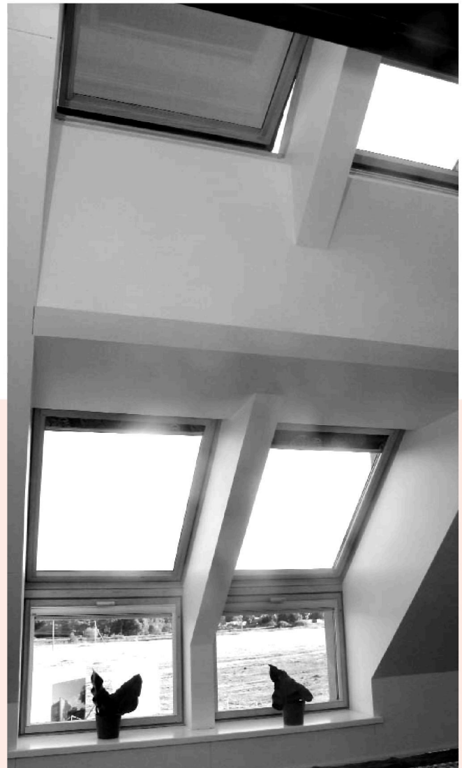
В «Активном доме» установлено 24 мансардных окна VELUX с энергосберегающим покрытием и 15 фасадных окон Gaulhofer
